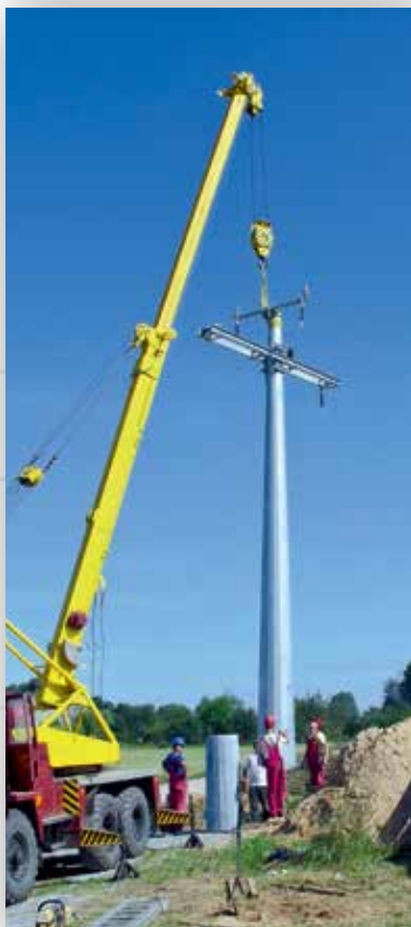
Montaż słupa
